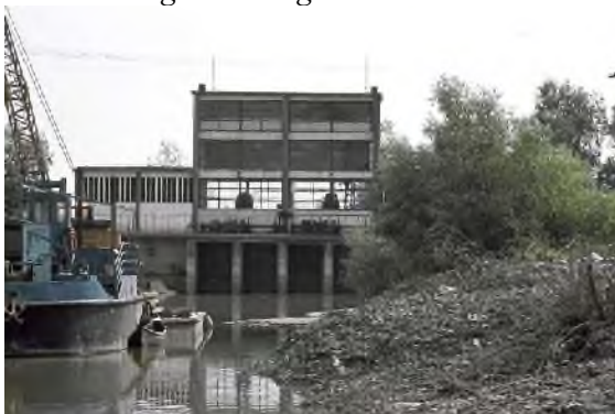
Gemaal van de Pardina polder in de Donau delta. Dit gemaal is zowel op aanvoer als op afvoer te bedienen
