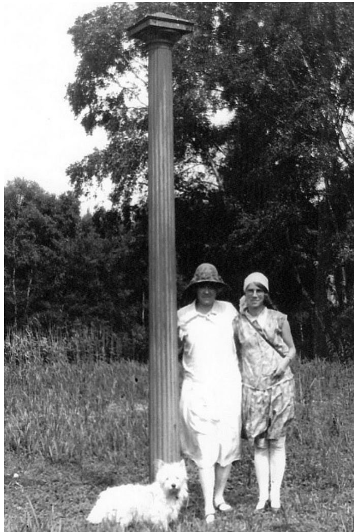
Figuur 3. Holme Post in 1851 geïnstalleerd aan de oppervlakte toen de Whittlesey Mere werd drooggelegd (bron: County Record Office, Huntingdon)
