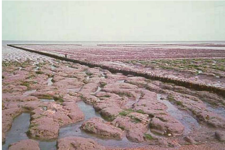
Figuur 7. Insluiting door middel van houten kribben ter verbetering van de natuurlijke sedimentatie in de Dengie Flat, in het zuidoosten van Essex (bron: Colenutt, 1999, foto D. Carter).
