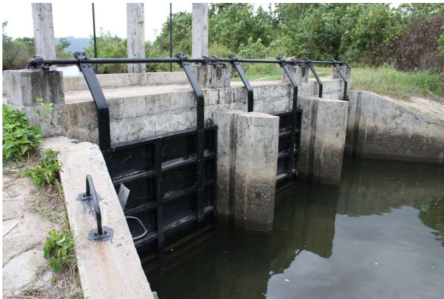
Figuur 4. Een van de uitwateringssluizen van de Prey Nub polders. Aan de polderzijde verticale schuiven en aan de zeezijde klapdeuren (plaatselijk baffles genoemd) (Emmerik en Piet, 2012)
