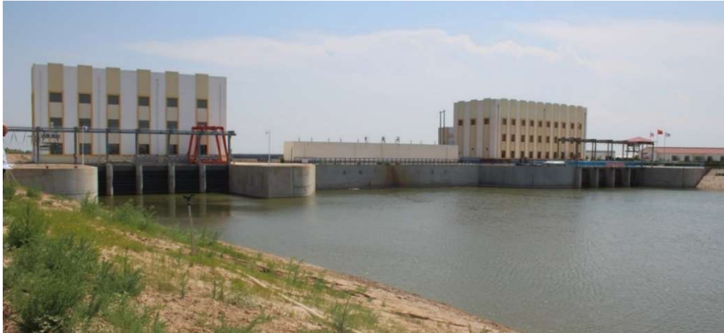
Figuur 3. Uitwateringsluis met aan weerskanten gemalen van Hetao Irrigation District en Ulansuhai Lake naar Gele rivier
