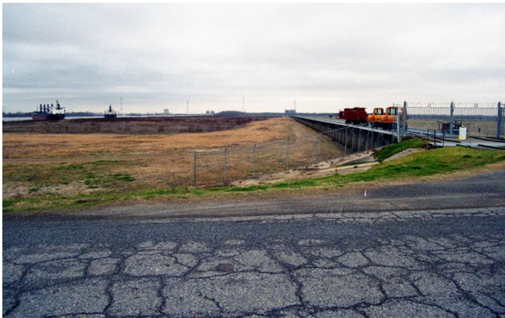
Figuur 5. De Bonnet Carré Overlaat 19 km bovenstrooms van New Orleans om hoogwater van de Mississippi rivier naar het Pontchartrain meer af te leiden
