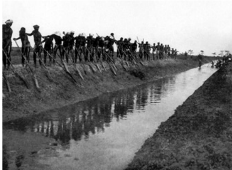
Traditionele aanleg van een Bolanha dijk en drain door Balantas
